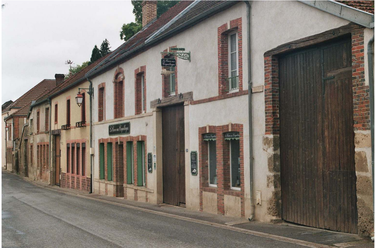
Photo 2: La Cave aux Coquillages – La plaque au-dessus de l'entrée dit tout!
