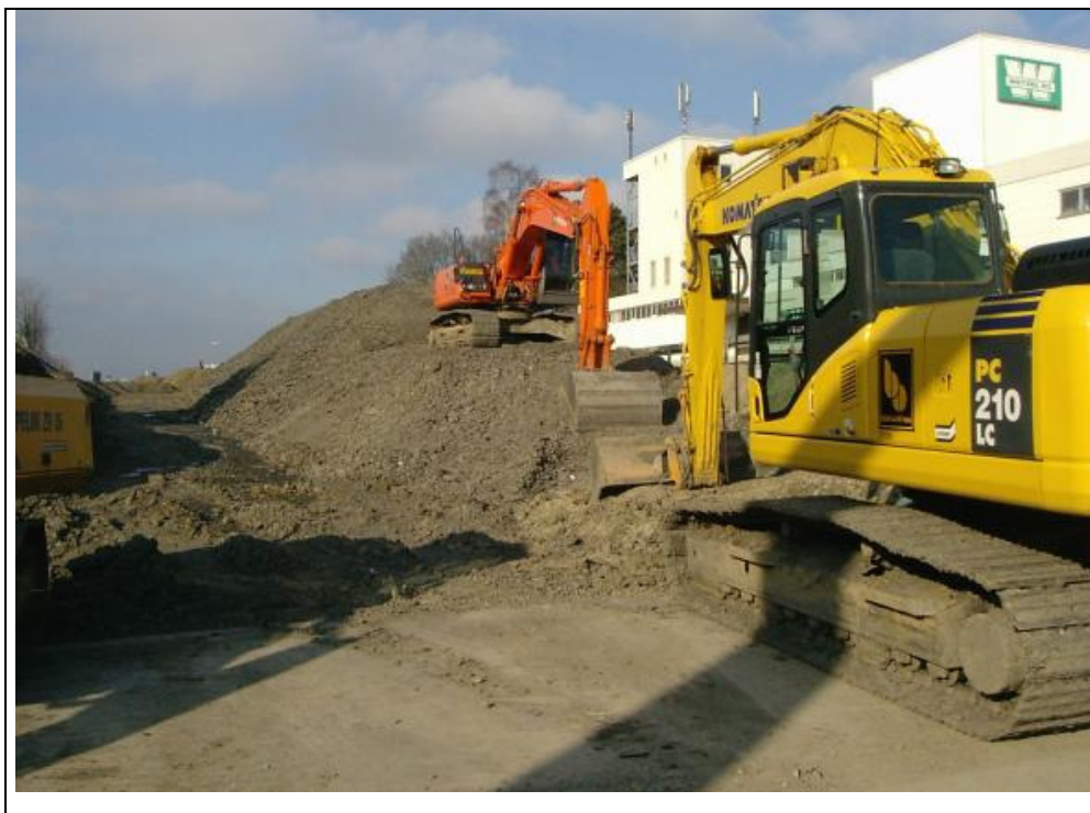
Bagger auf der Baustelle im Februar 2006 - auf der gegenüberliegenden Straßenseite ist der Firmenkomp-plex der Wetzels KG (Klebstoffe) zu erkennen
