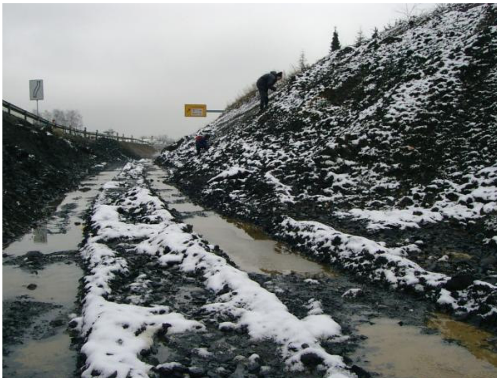
Die Baustelle im Februar 2005, noch waren zahlreiche Lesefunde möglich
